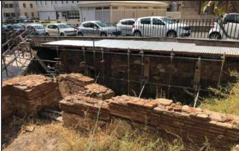
*Fig. 11 Muro di età basso medievale con puntellatura di messa in sicurezza provvisoria (lato interno).*
