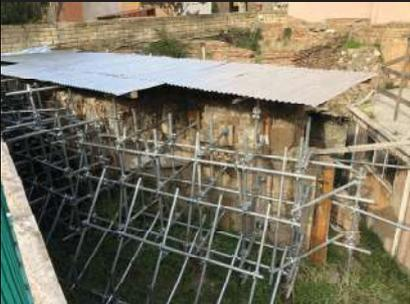
*Fig. 10 Muro di età basso medievale con puntellatura di messa in sicurezza provvisoria (lato esterno).*
