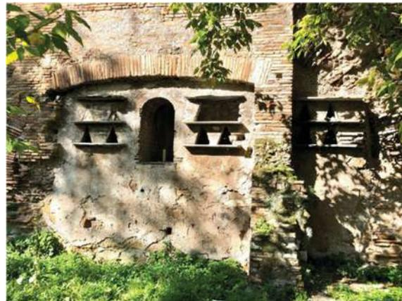
*Fig. 142 Sopra: Tamponatura di un arco con strutture alla maniera di un colombario (sulla sinistra rispetto all'entrata dell'Ospedale).*
